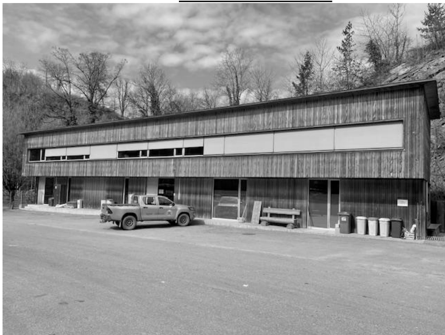
Verwaltungsgebäude der Agrar und BWR-Heizwerk, Walgaustraße 19
